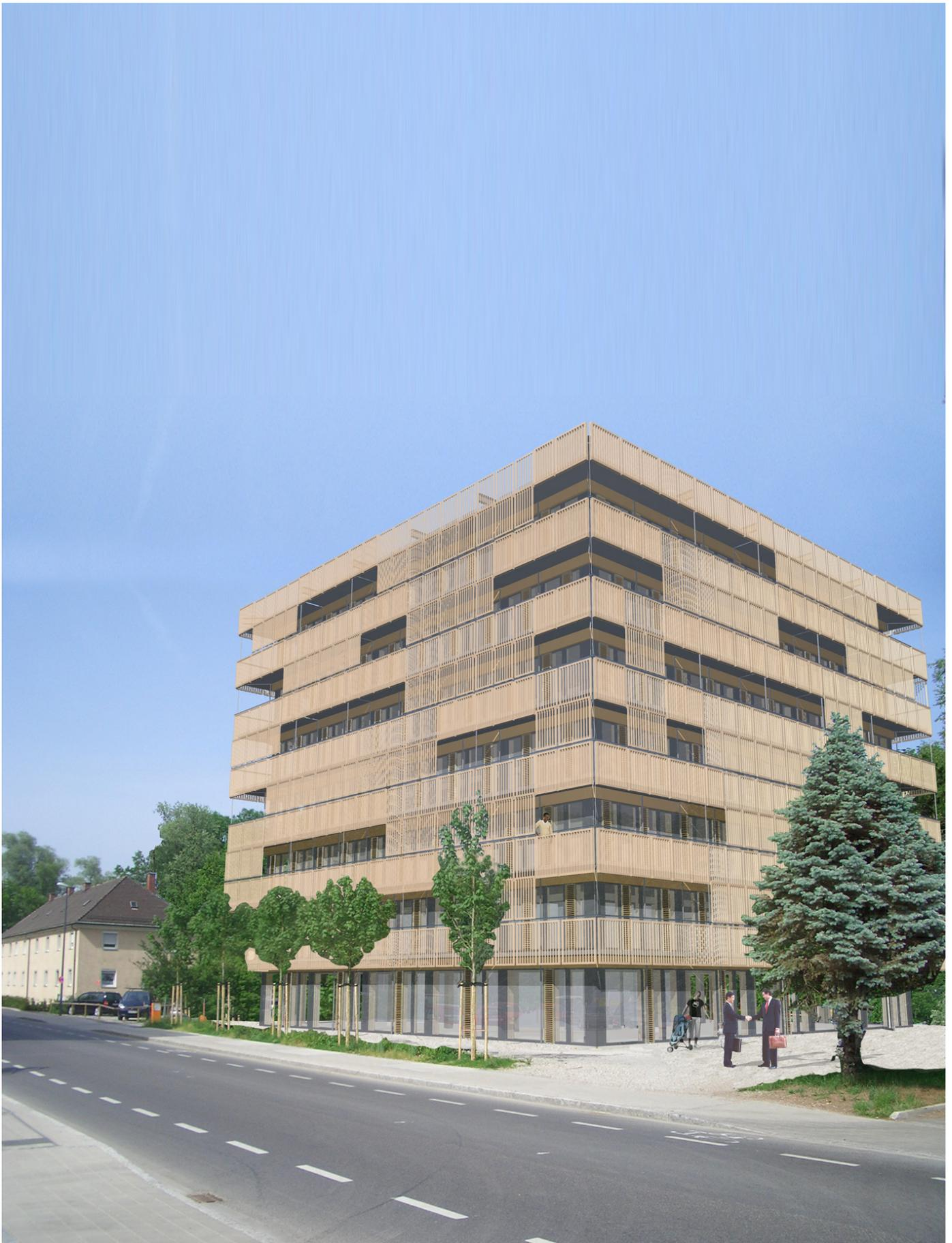
· Abb. 4.81 Perspektive: Vertikal verschiebbare Holzlamellen und Holzleichtbetonbrüstungen
