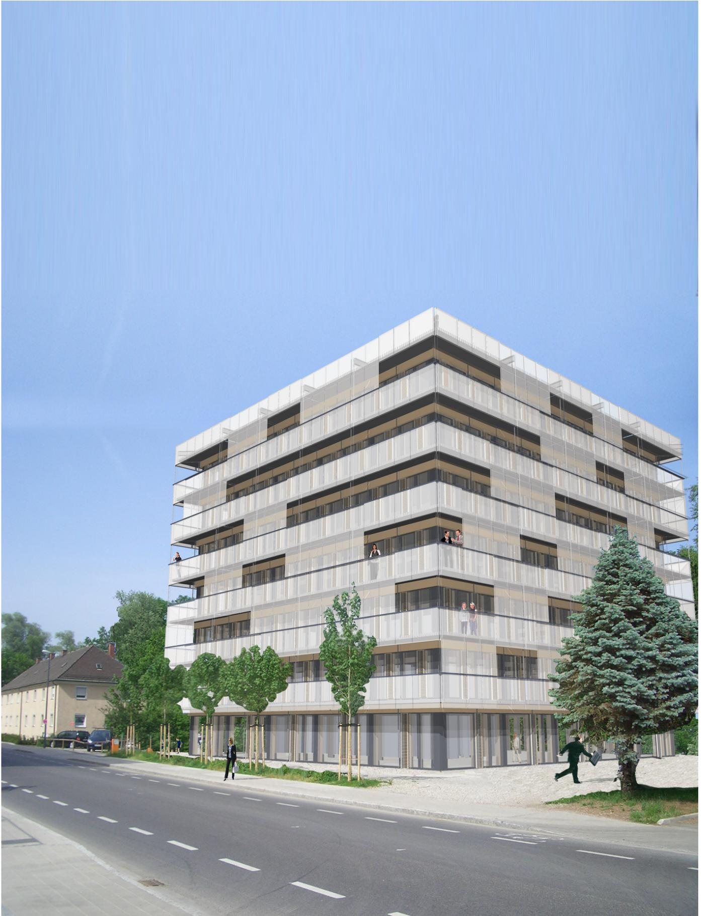
· Abb. 4.80 Perspektive: Vertikal verschiebbare Holzleichtbetonelemente und Holzleichtbetonbrüstungen
