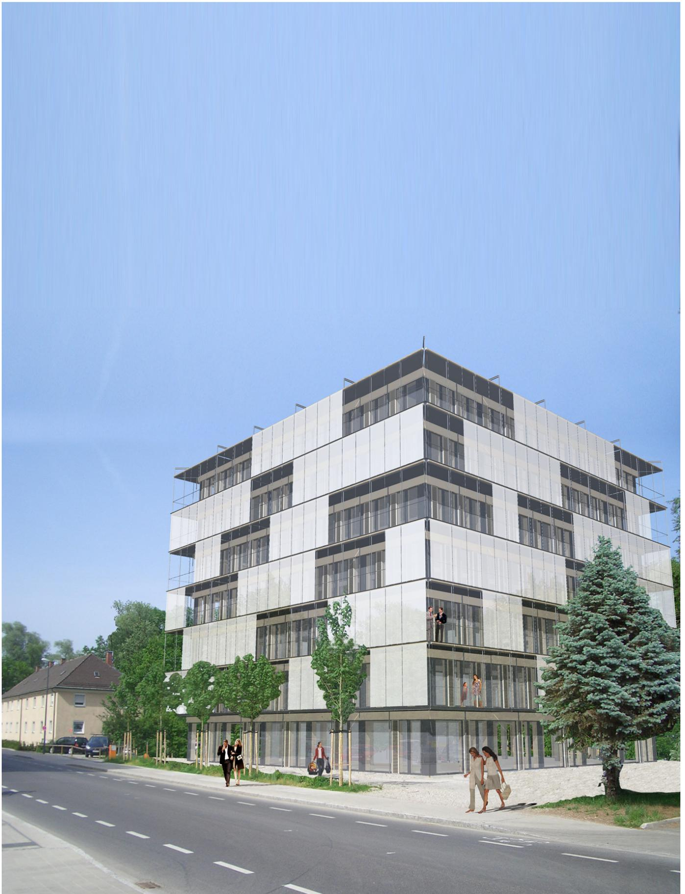
· Abb. 4.79 Perspektive: Vertikal verschiebbare Textilsegel
