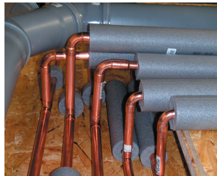
Abb 4.9 Montagetest der Installationsführung: Mit marktgängigen Rohren, Leitungen und Rohrdämmungen wird der minimalste Platzbedarf für die Installation von Wasser, Abwasser, Heizung und Lüftung in der horizontalen und vertikalen Trasse untersucht. Mit Hilfe des Versuchsaufbaus werden die Schnittstellen zwischen vertikaler und horizontaler Trasse sowie zwischen horizontaler Trasse und Weiterführung im Bodenelement analysiert.
