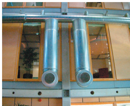
Flexible Installationen: Leitungsführung zwischen Trägerelementen und durch vorgefertigte Öffnungen des Trägers
