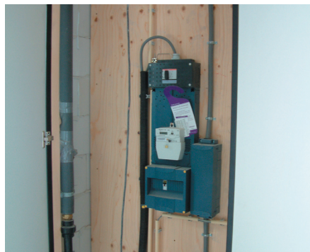
Semizentrale Technischeinheit für jede Wohneinheit : zugänglich über den Laubengang oder den Flurbereich
