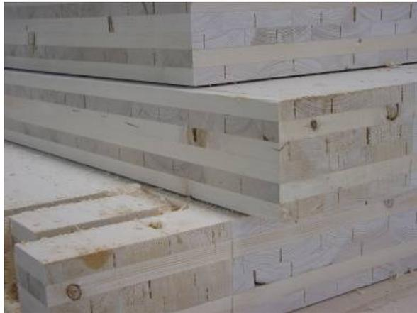
Abb. 5-1: Brettsperrholzelemente (Foto: Finnforest – Merk)
