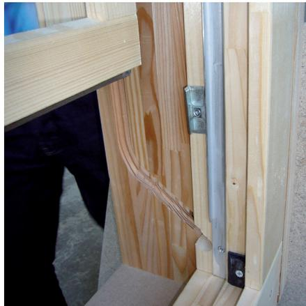
**Bild 4.11** gekröpfte Nut am Flügelfußpunkt
