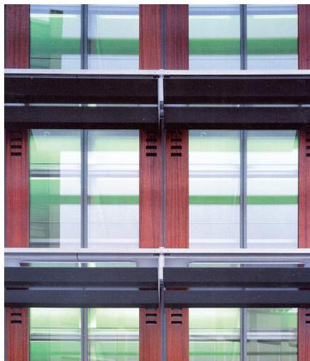
**Bild 1.2** Festverglasung mit opaken Lüftungselementen aus Holz (Drehflügel); ZVK Wiesbaden, Arch. Herzog+Partner
