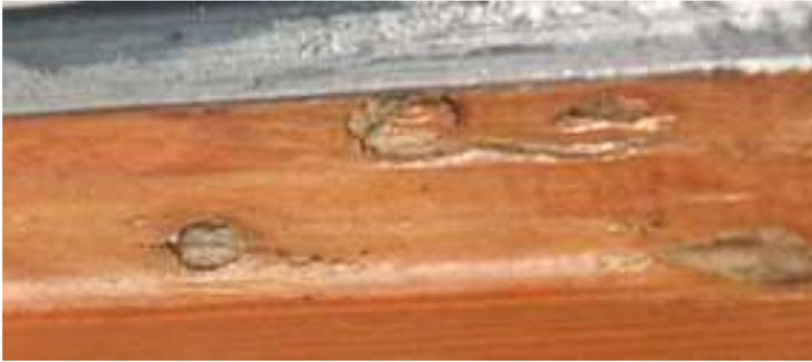
Abbildung 15: Anstrichschäden durch Hagelschlag
