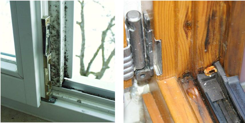
Abbildung 17: Schimmelpilzbildung und Holzerstörung durch Pilzbefall als Folge von Tauwasser in den Falzen
