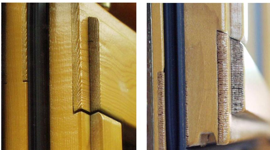
Abbildung 13: Offene Fugen an Rahmenverbindungen aufgrund unzureichender Verleimung als häufige Schadensursache bei Fenstern
