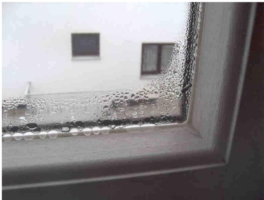
Abbildung 20: Tauwasserbildung im Randbereich des Isolierglases
