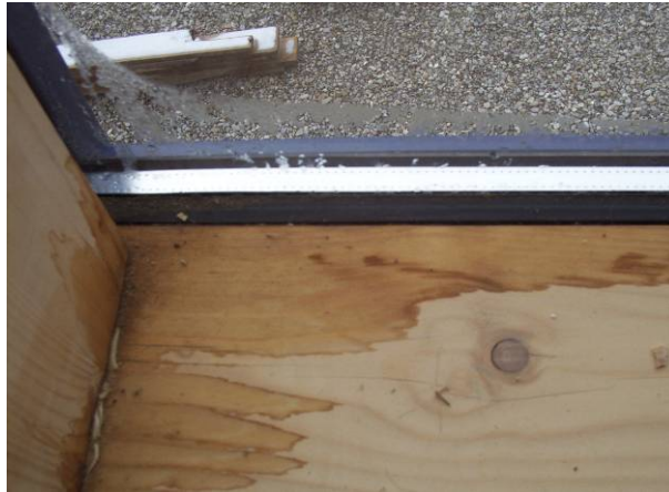
Abb. 2 Beispiel von Holzschäden durch Tauwasser am Scheibenrand.
