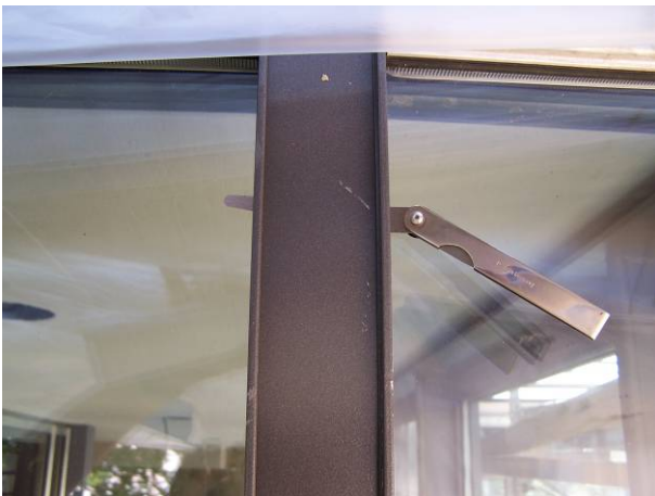
Abb. 5 Beispiel einer nicht ausreichenden Druckprofilverschraubung
