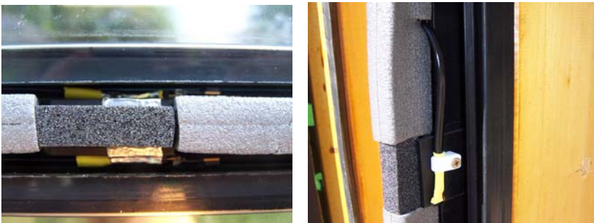
Abb. 74 System A Einbau der Sensoren im Falzraum
