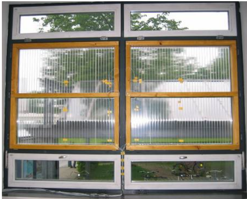
Abb. 23 Innenansicht in der Testelemente in der FH-Fassade
