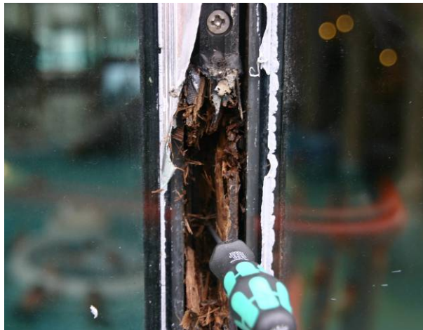
Abb. 7 Beispiel eines Holzschadens durch fehlender Dampfdruckausgleichsöffnung.
