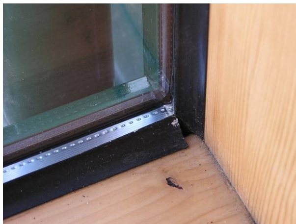
Abb. 3 Beispiel einer offenen raumseitigen Dichtungsecke
