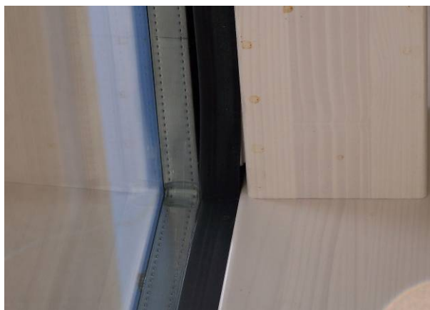
Abb. 4 Beispiel einer offenen raumseitigen Dichtung
