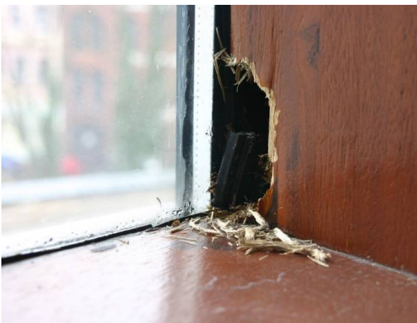
Abb. 6 Beispiel eines Holzschadens durch Wassereintritt
